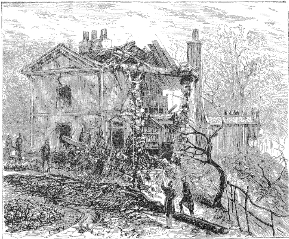
L'explosion de poudre du 3 octobre à Londres. — Vue de la maison du gardien de Regent's Park après le sinistre.
